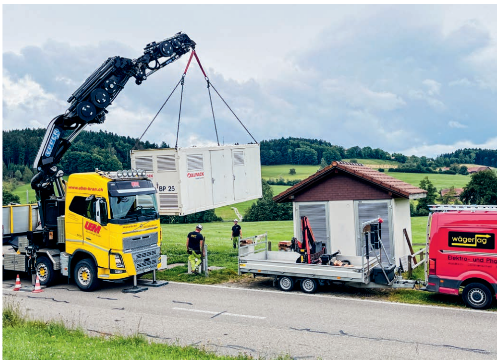
Sanierung Trafostation Hohfirst / Quelle TB Waldkirch
